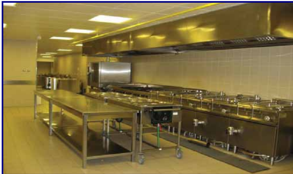
Slika 16. Odgovarajući podovi, zidovi i stropovi.
